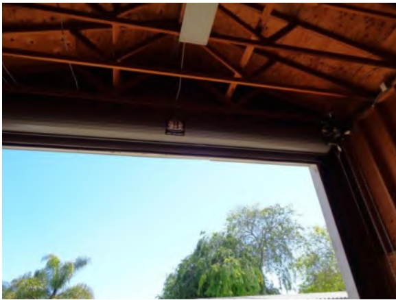
0042065a 4/2/2024 Overhead door to hay storage Hay barn
