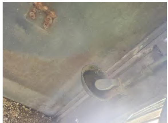
0042093e 4/2/2024 Steel waterer Barn 30-39
